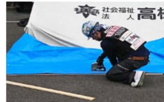
野地板を使用し、辺で押さえる
