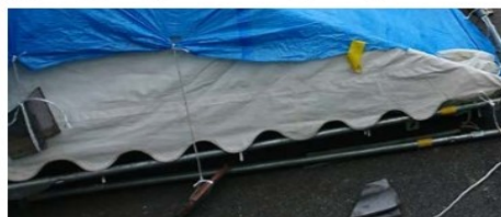
シートの裾に瓦やブロックが宙づり ひもが切れると落下し危険性大
