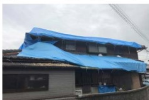
シートの押さえがなく 擦れて劣化が早まる 飛散の危険性もあり
