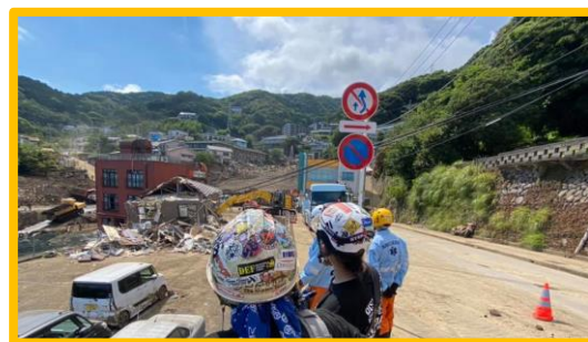
熱海市土石流災害の現場
