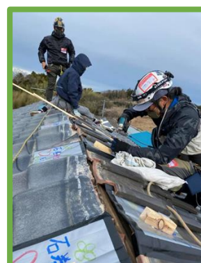
アシスト瓦を利用した応急処置
